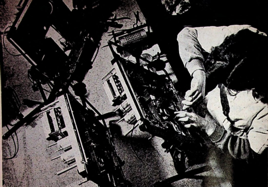
Afb. 2 - Elk palletje, borgveertje, elke condensator, schroefje e.d. wordt stuk voor stuk door rappe meisjeshanden aangebracht. (Foto Telefunken)
